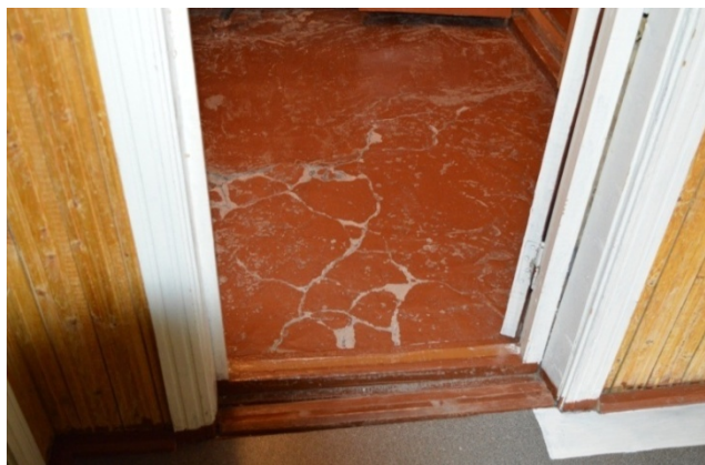
Вход в общий туалет
